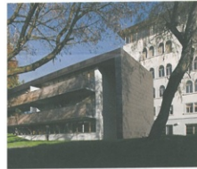
Der neu gebaute Pavillon öffnet sich zum Park mit den Wohnungen vorgeplanten, durchgehenden Balkenbündeln und großen Fensteröffnungen. Der verputzte, massive Baukörper erhielt zusätzlich eine Hülle aus vorverleitetem Kupferblech. Baumeister: ARGE Hiltl & Jochle und Niggelohs Bau, Dachdecker, Spiegler, Ruch Spiegler und Dachdecker Ges. m. b. H.; Fenster: Passenberger Hochbau und Holzindustrie GmbH; Zech Hofmeister GmbH & Co.
